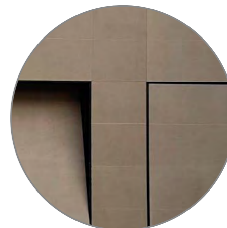
Particolare porta filo muro Détail porte affleurante
